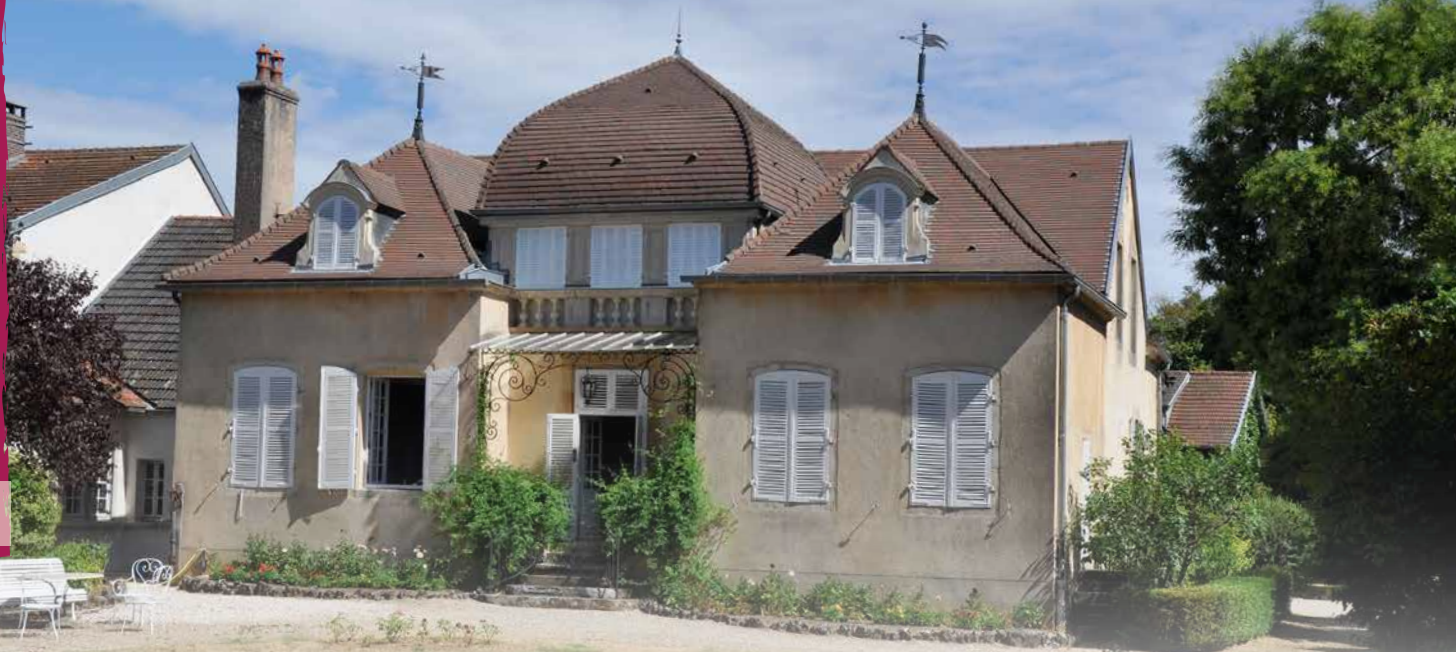
Maison privée acquise par Cl. Noisot en 1830 à Fixin. © M. Lompré
